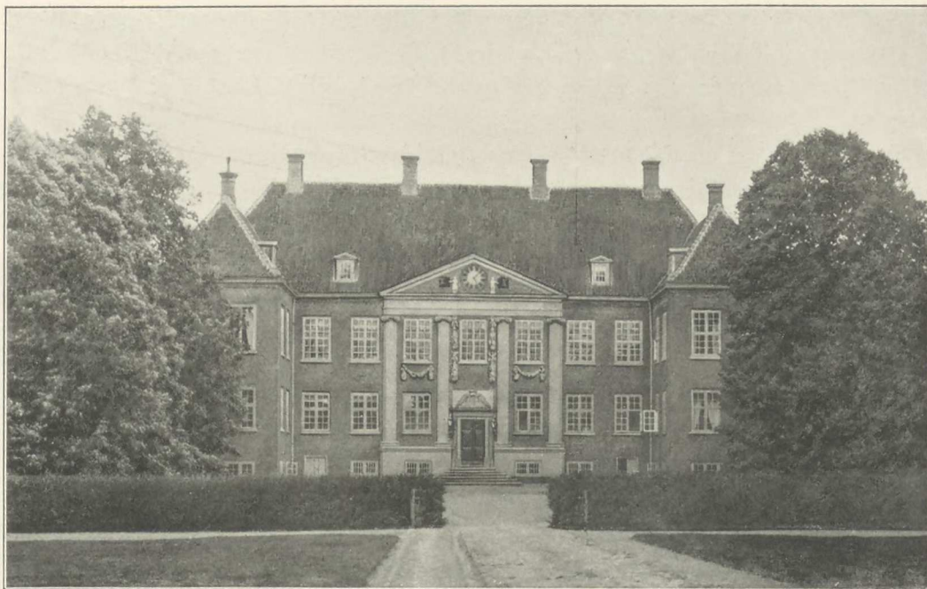
NYSØ HOVEDBYGNING, SET FRA GAARDSIDEN. EFTER FOTOGRAFI.
