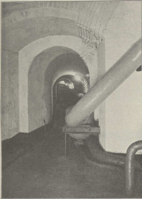
FIG. VI. BETONTUNNEL FRA KJEDELHUSET TIL RAADHUSET
