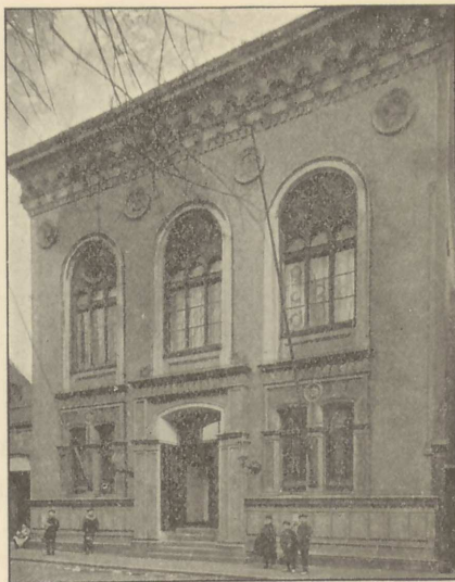
Aarhus Haandværkerforenings Bygning.
