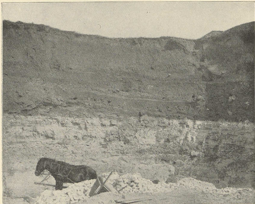
Fig. 43. Regelmæssigt aflejret Moræneleret ovenpaa Bryozokalk. Kagstrup Kalkværk (efter Fot. af Forf.).
