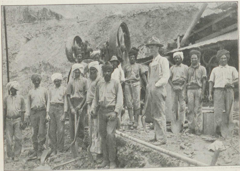
Hinduiske Arbeidere ved Canalen.
