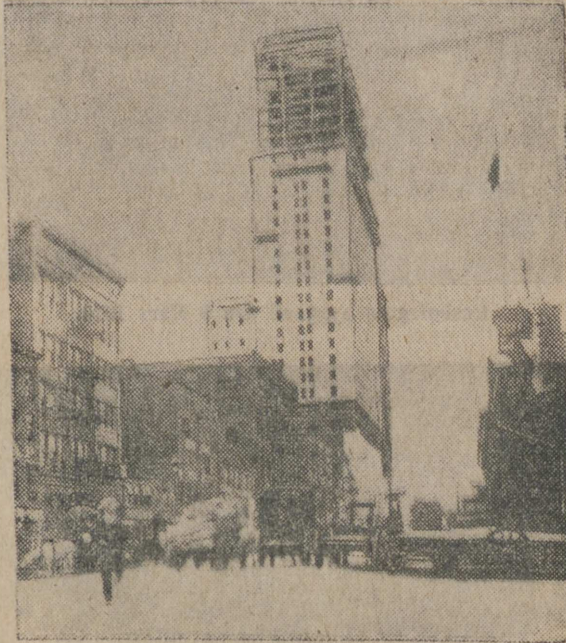
Skyskrapare under byggnad i Newyork. (Aug. 1910.)
