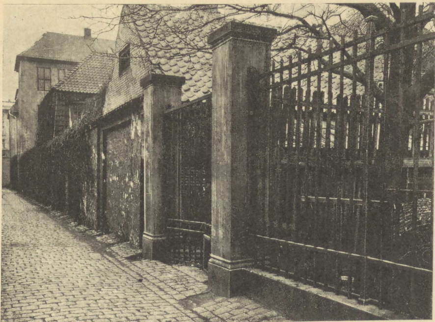
Gitterport af Støbejern, det kgl. Frederiks Hospital.
