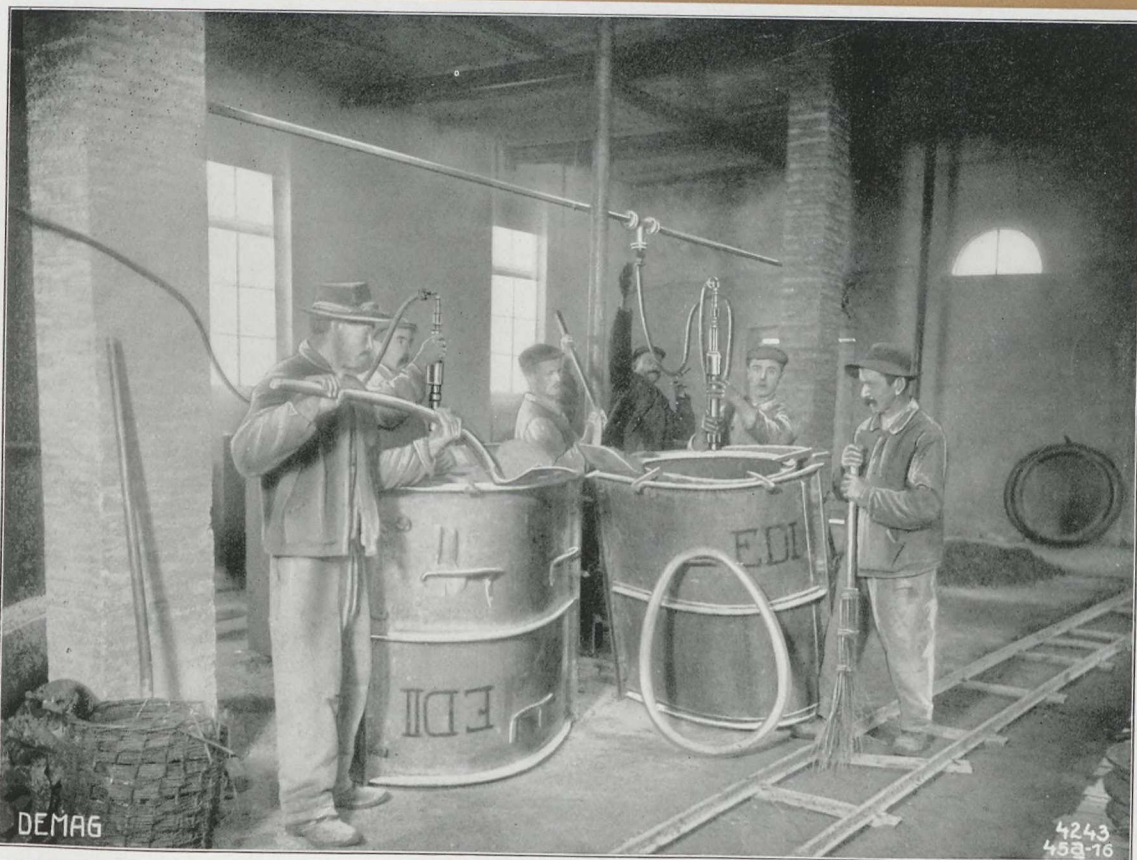
STAMPFER BEIM ANFERTIGEN VON BETONRÖHREN
