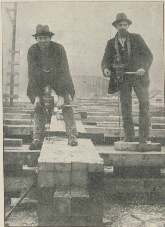
Fig. 6. Hopborrning af balk och pelare. Byggmästare A. Jeppsson, Karlstad.
