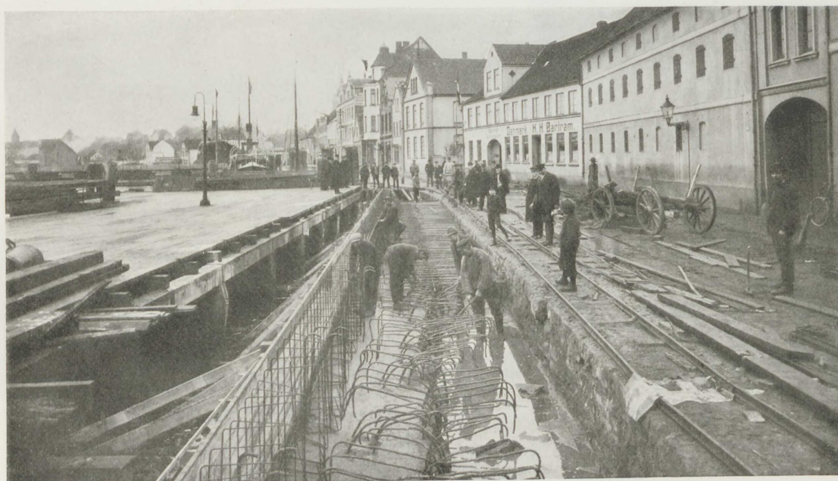
KAIANLÆG I SØNDERBORG VED ALSSUND.
