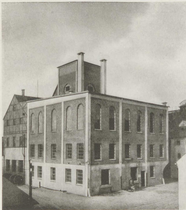
FABRIKSBYGNING I RANDERS.
