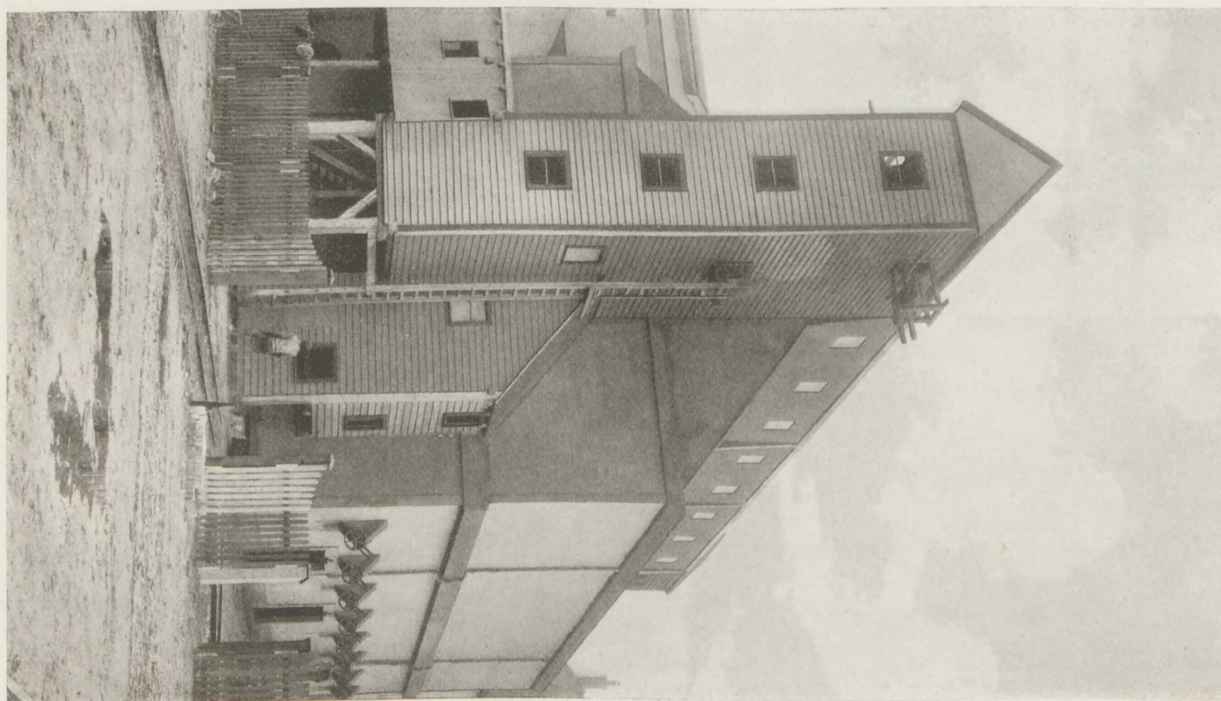
KIES- OG SLAGGESILO I KASTRUP
