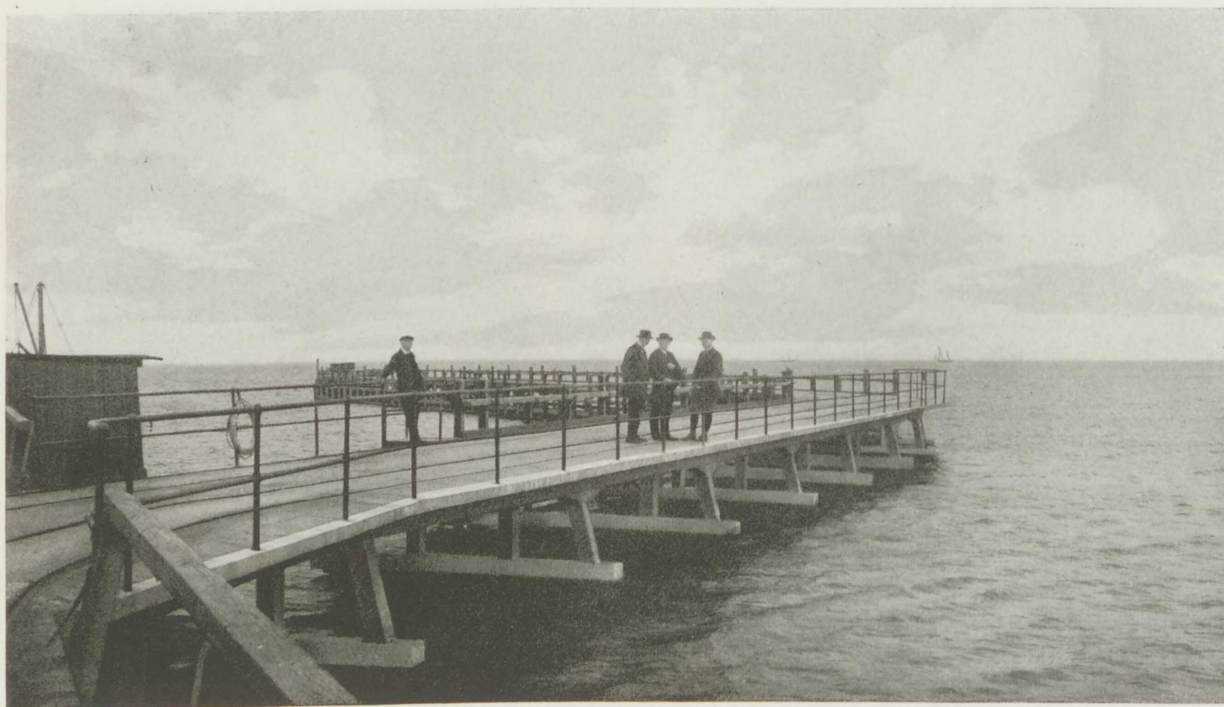
PIERANLÆG VED KASTRUP.
