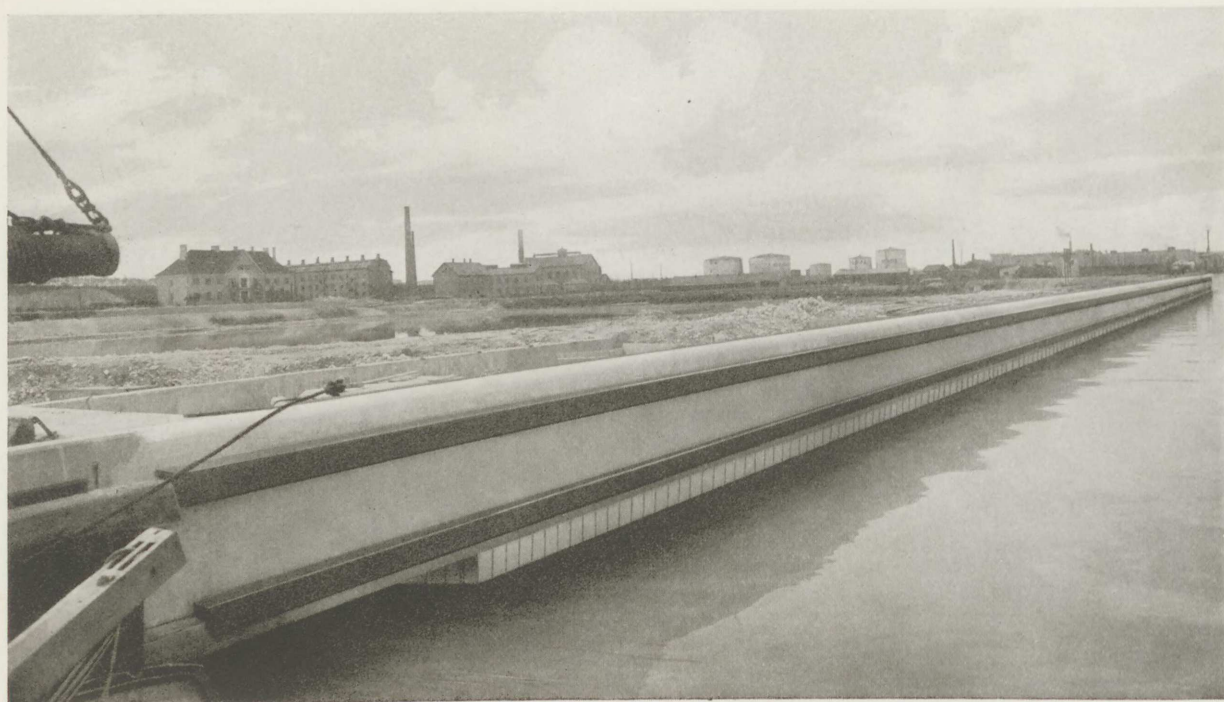
KAIANLÆG VED AALBORG.
